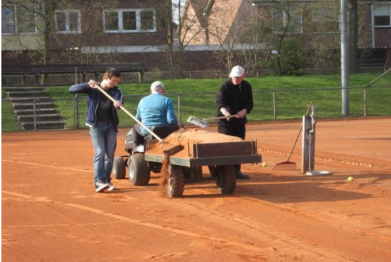
Afbeelding: gravel opbrengen
