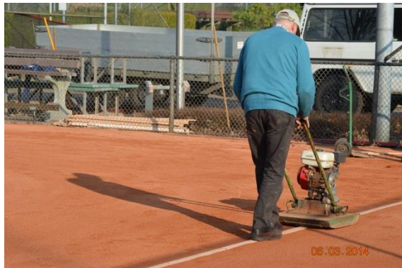
Afbeelding: natrillen met lichte trilplaat
